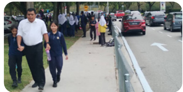
Pemasangan pagar jenis 'anti-climb' di Sekolah Kebangsaan Putrajaya Presint 16(2) berjarak 130 meter. Pagar ini dipasangkan bagi mengelakkan masalah keselamatan pelajar sekolah semasa menunggu ibu bapa di tepi Jalan P16.
