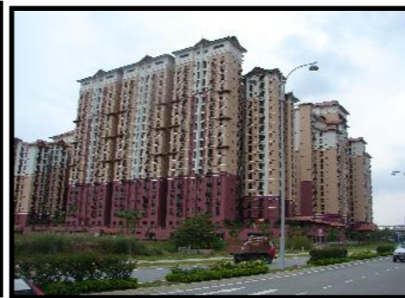
Pembangunan Apartmen di Presint 14
