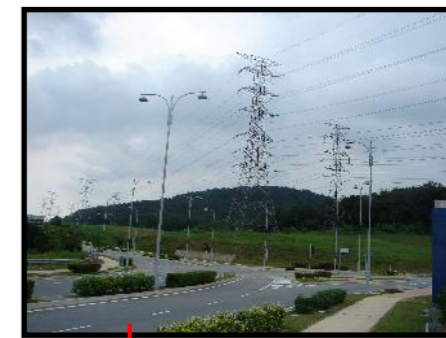
Laluan Penghantar Elektrik di Presint 14
