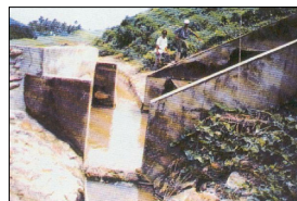
Kaedah takungan (Sump)
