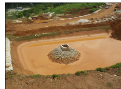
Perangkap mendap (Silt trap)
