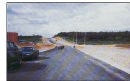
Turapan jalan raya
